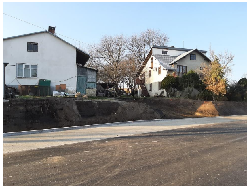
Fot. 24 Zatoka autobusowa km 5+942
