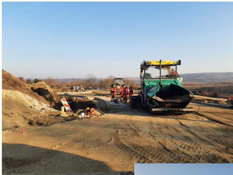
Fot. 29 DG nr 116460R km 0+025.
