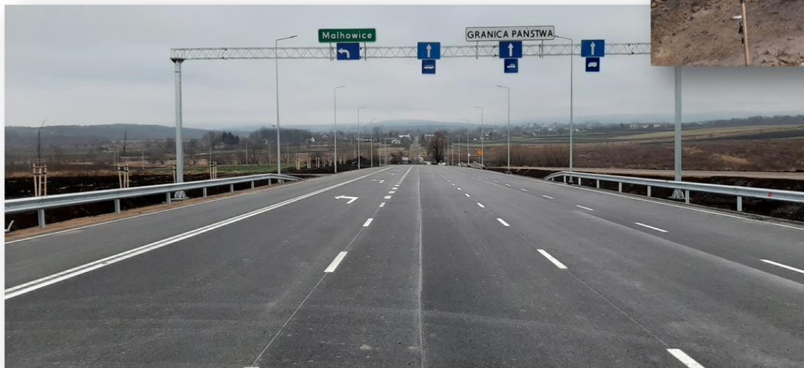
Fot. 27 Jezdnia 885 km 6+100.
