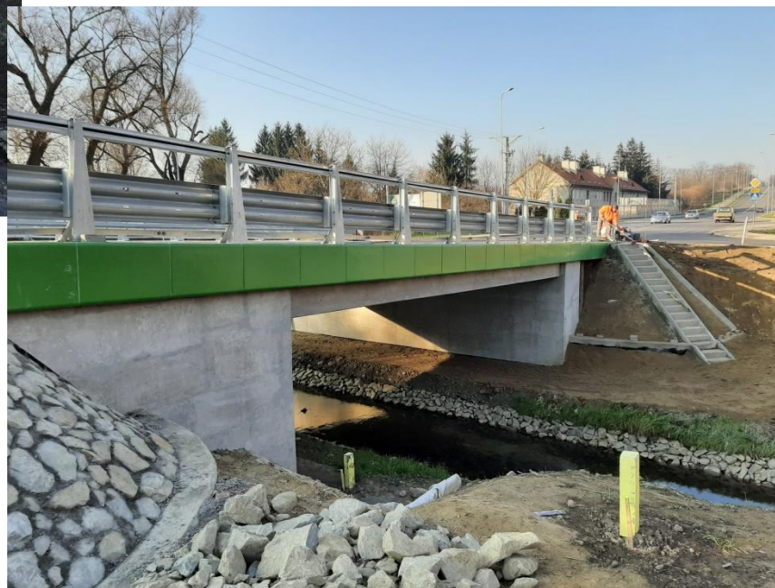
Fot. 2 Most M1 SL.
