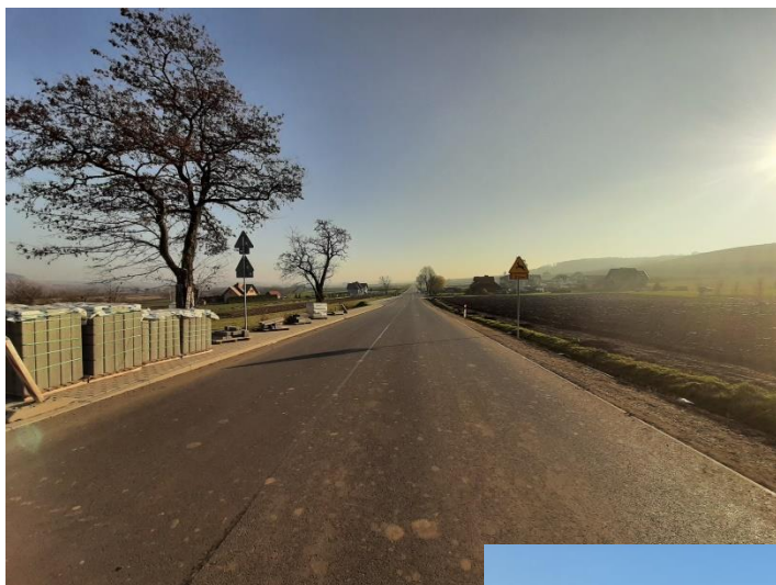
Fot. 7 Jezdnia 885 km 0+400.
