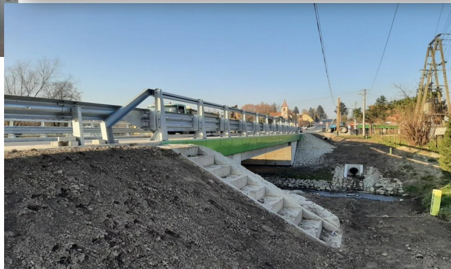
Fot. 15 Most M2 SL.
